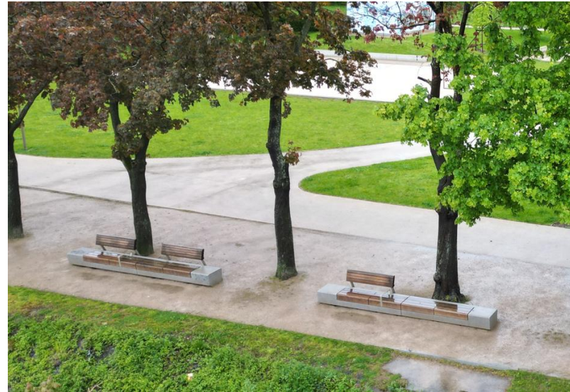
Zweiteilige Wegebefestigung mit aufgehelltem Asphalt und wassergebundener Kalksplittgranulat-Decke wie am Bsp. Insel Grafenwerth (Phossel-Beschichtung (Polymere-Beschichtung auf Asphalt))
