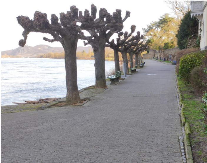
Wegebefestigung mit Betonpflaster und dunklem Splittgranulat
